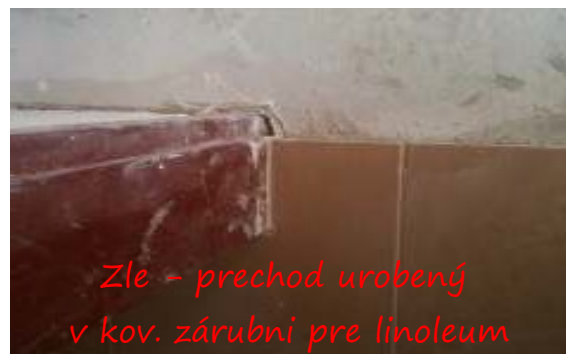
Riešenie styku nerovných podláh pri bezprahovom riešení - posuv. dvere
